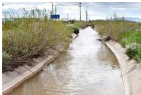
Un fossé maçonné sur le terrain
