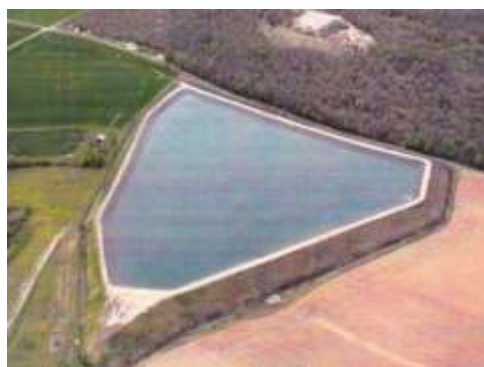
Retenue d'eau artificielle numérisée en surface en eau maçonnée
